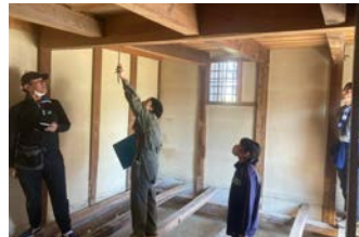
土蔵の痕跡調査の様子
